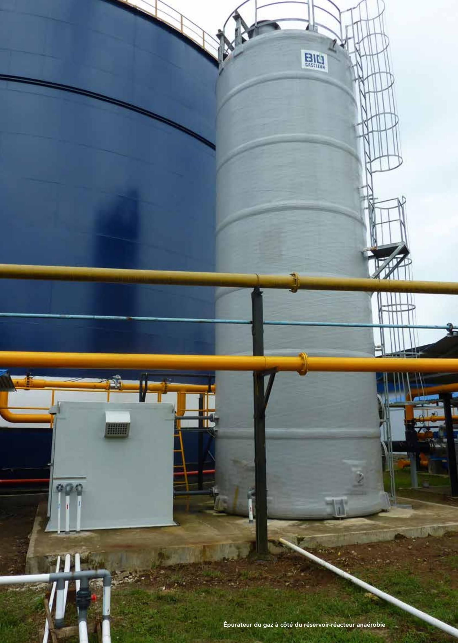
Épurateur du gaz à côté du réservoir-réacteur anaérobie
